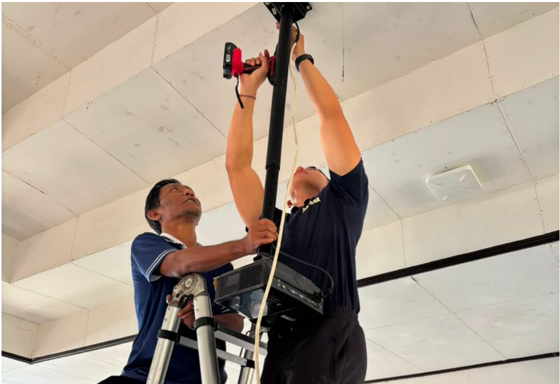
Pemasangan LCD Proyektor – Lab DKV
